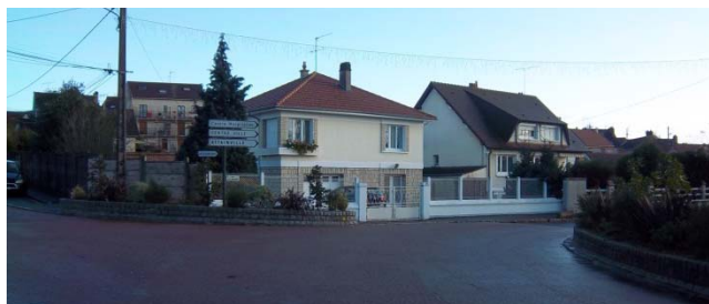
Entrée Ouest, RD 909
